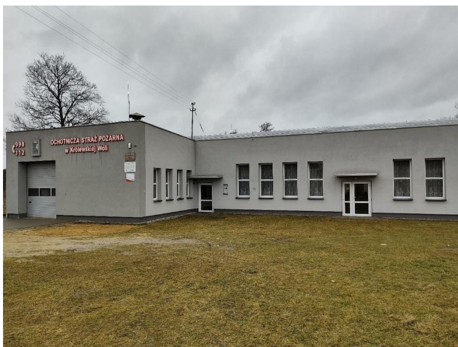
Świetlica Wiejska z Remizą OSP Królewska Wola
